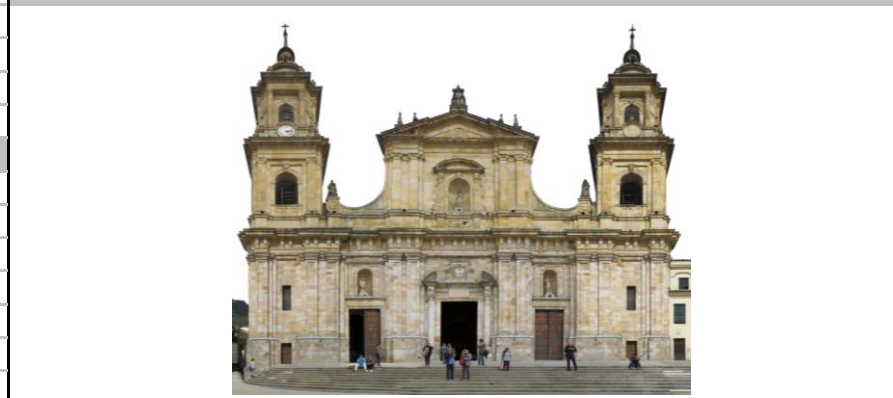
Fuente: Equipo Fotografía PEMP Patrimonio Inmueble
